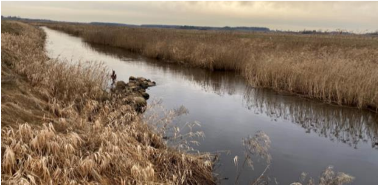
2.6 pav. Vyžuonos upėje įrengta upės vagos bioinžinerinė priemonė – akmenų metiniai
